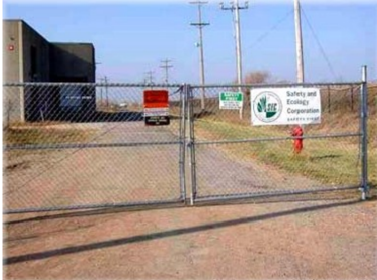
Twin Cities Army Ammunition Plant – Bâtiment 502 isolé par une grille. La pancarte indique que la firme de nettoyage Safety and Ecology Corporation occupe les lieux.
