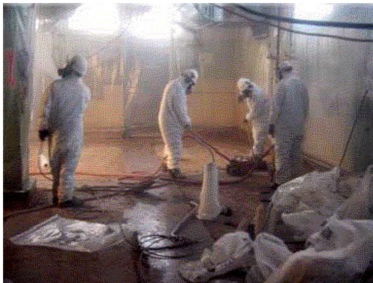
Les employés du SEC déinfectent le Bâtiment 502 du TCAAP.
