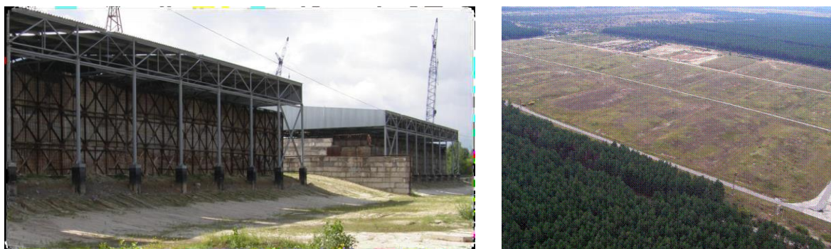
Figure 1: Installations de Podlesny (à gauche) et de Buriakovka (à droite).
