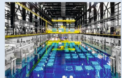
Vue d'une piscine d'entreposage des assemblages combustibles de l'une des usines d'ORANO la Hague
