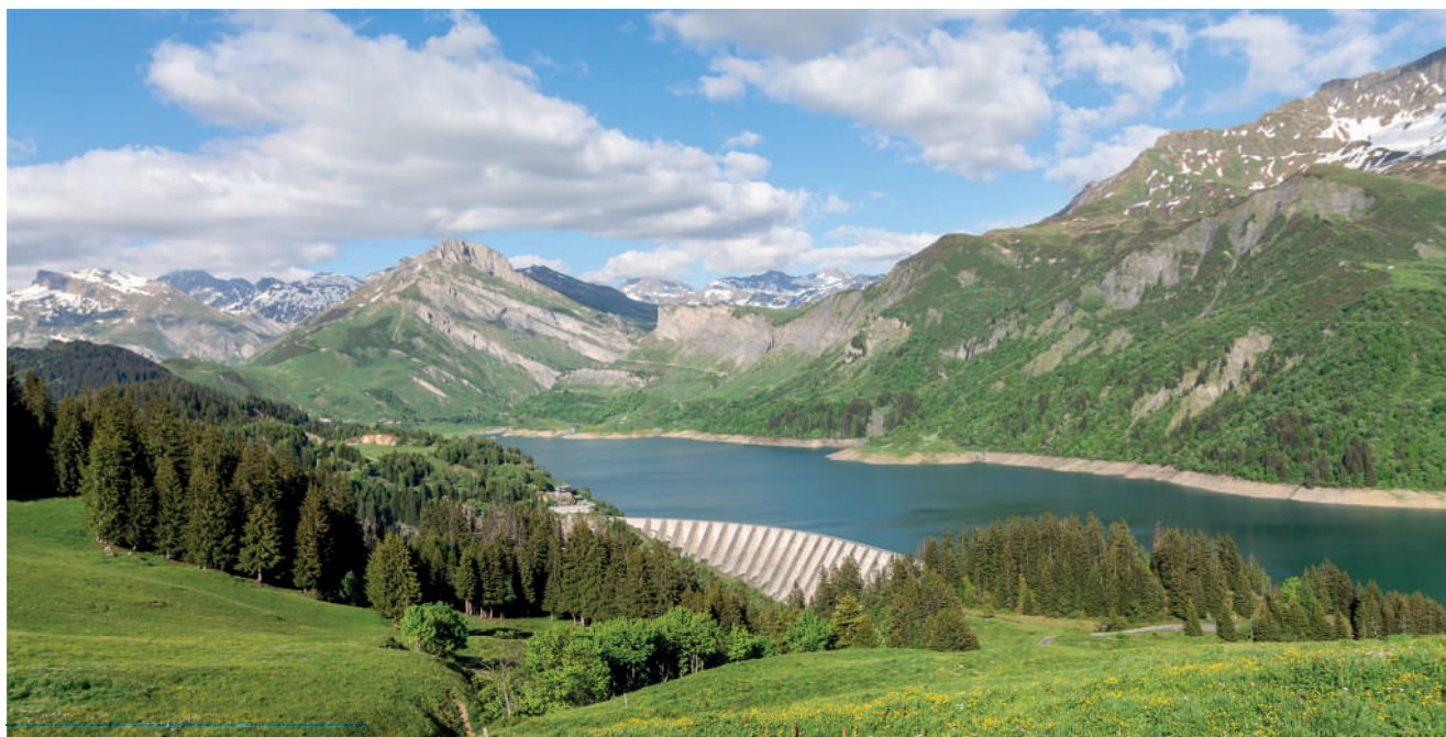
Barrage de Roselend. France P.
